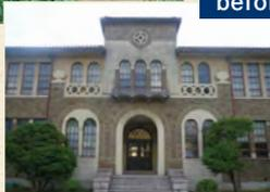
教室の窓に当初の鋼製建具が唯一残る理学館東面、地金は浸水により錆びた箇所以外は今もなお健全で、分析調査により純度の高い貴重な鋼材であると判明しました。
