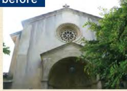
屋根から墨が流れたような入り口周りと黒カビに覆われた西・北面の汚れを洗い落とし、傷んだ窓枠の塗膜とパテが修理されたチャペルは当初の輝きを取り戻し微笑むようです。
