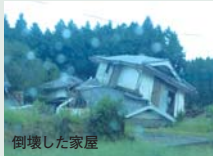
倒壊した家屋
