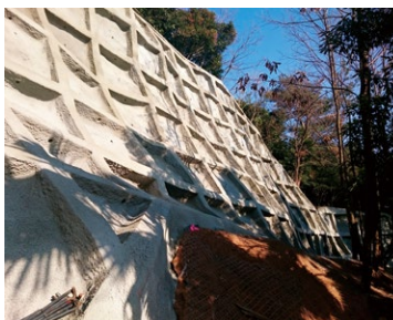
耐久性に優れたフリーフレーム工法を採用した法面保護工事。
