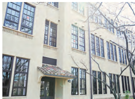
改修後の西面
