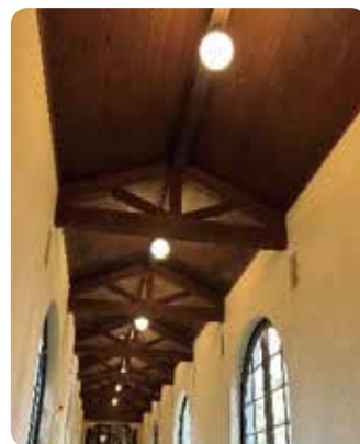
▲ 照明の増設、高ワットLEDへ取替え
